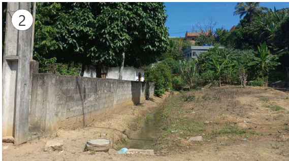
Imagem 02: Curso d'água vertendo no interior do lote. Risco de transbordamento nas adjacências nos períodos de chuvas intensas. Fonte: André Luiz (2024)
