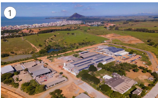
Figura 01 – Imagem aérea do Polo Industrial de Piúma Fonte: Google
